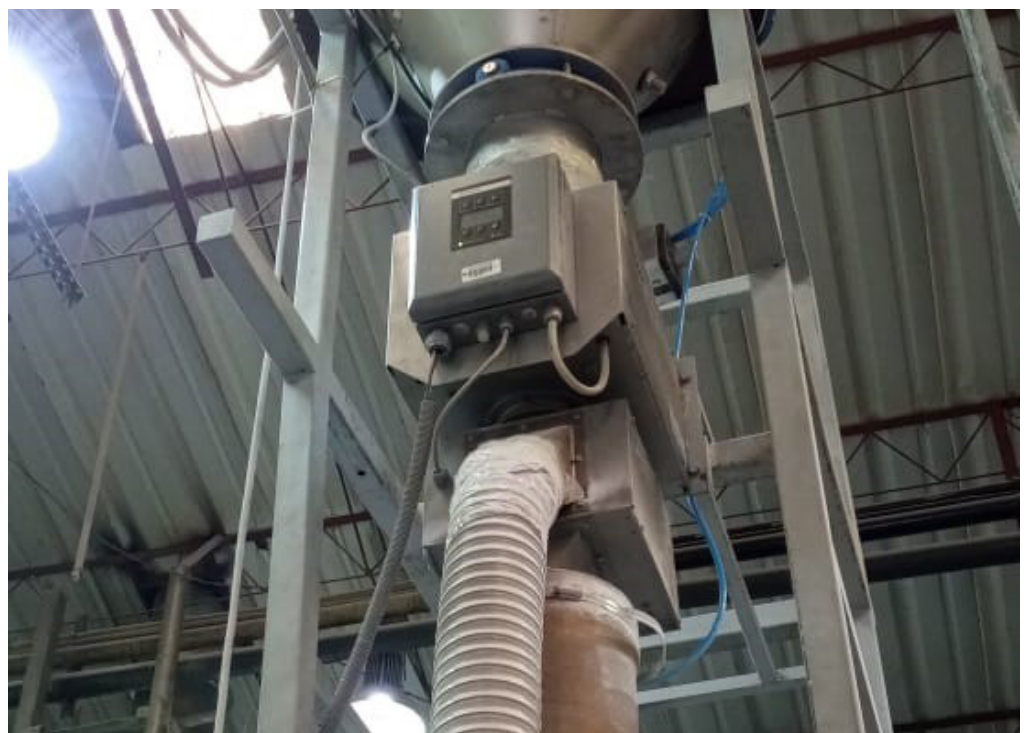
Metallabscheider RAPID VARIO-FS zum Schutz eines Pelletierextruders für PVC.
